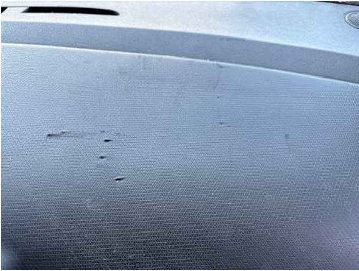
Innenraum (Diverse Schäden)
