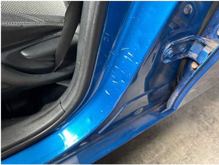
Schweller links (Kratzer, Delle)
