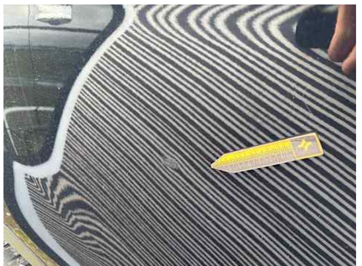
Türe hinten rechts (Delle)
