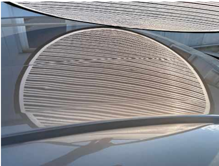
Dach (Delle, Kratzer)
