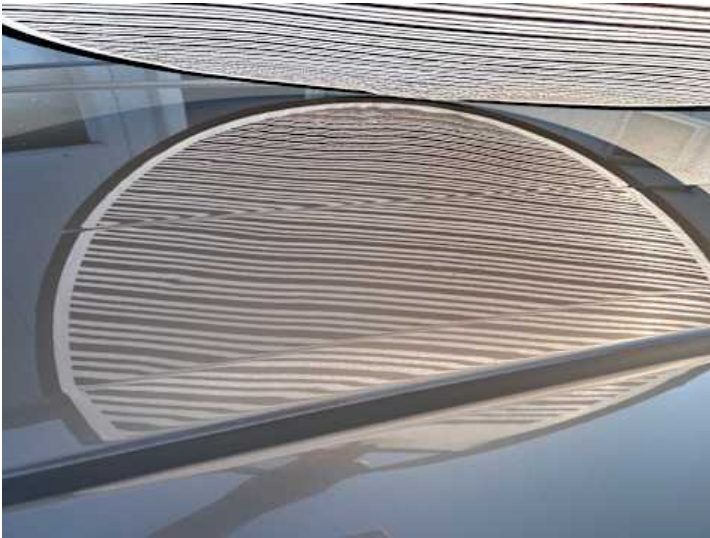
Dach (Delle, Kratzer)
