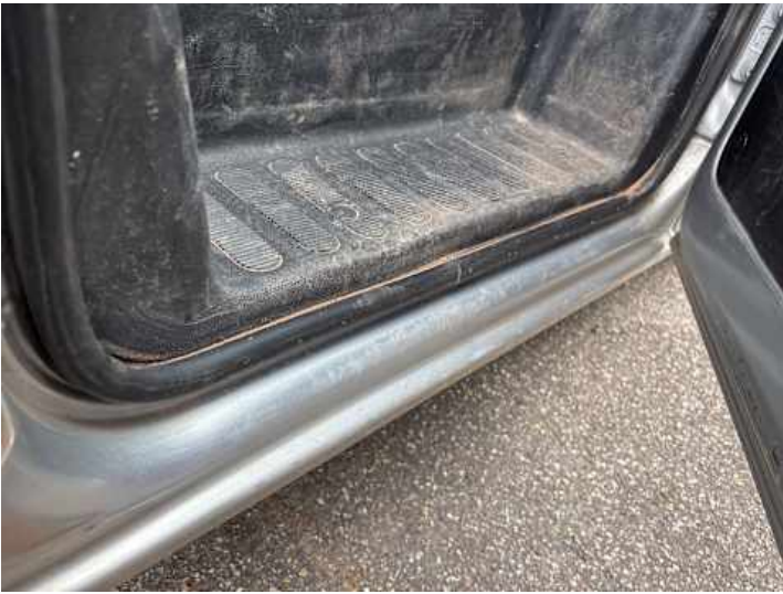
Schweller rechts (Lackschaden)
