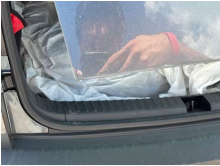
Heckklappe (Unsachgemäß instand gesetzt)
