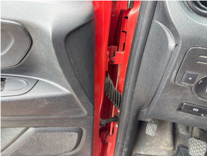
Innenraum (Anderer Schaden): Türfangband macht Geräusche
