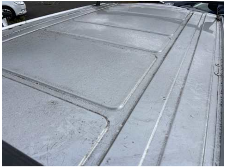
Dach (Delle, Verformung, Kratzer)
