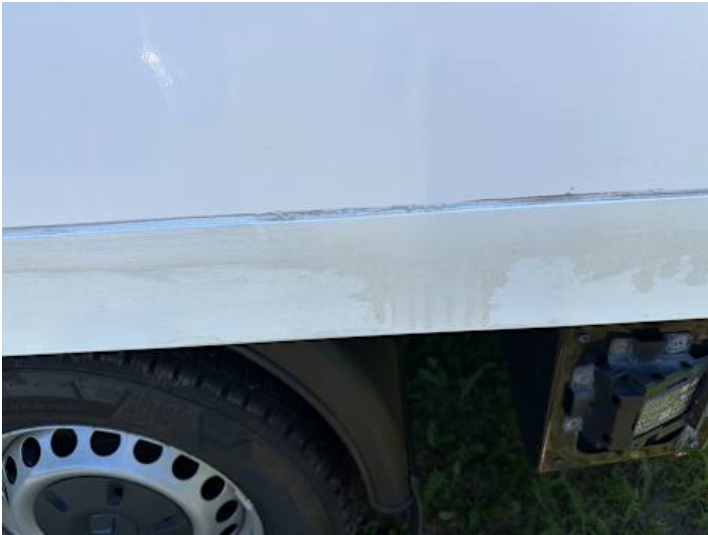
Seitenteil hinten links (Anderer Schaden): Lack abgeblieben
