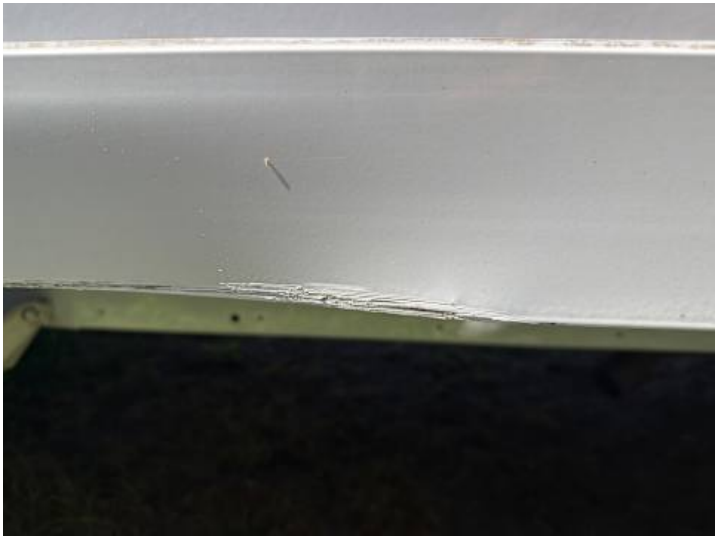
Schweller rechts (Verformung)
