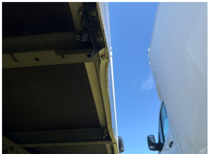
Schweller rechts (Verformung)
