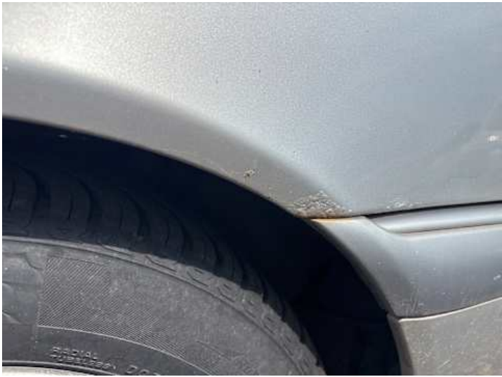
Seitenteil hinten links (Rost, Lackschaden)
