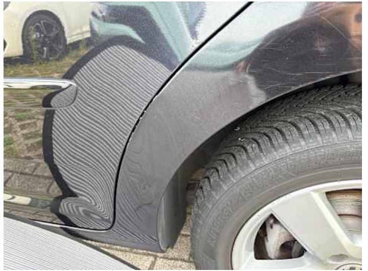
Seitenteil hinten links (Unsachgemäß instand gesetzt, Verformung)
