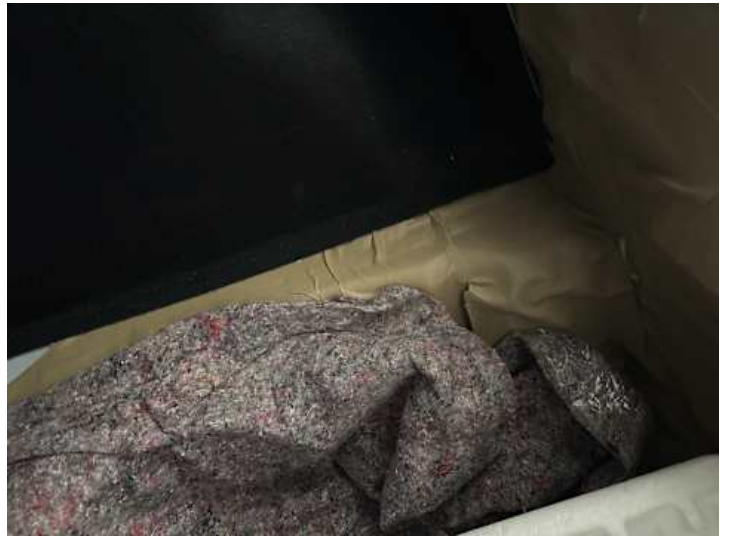
Innenraum (Anderer Schaden): Unsachgemäß instand gesetzt
