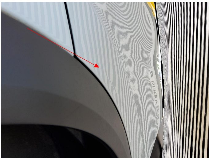
Bild 3: Außen, Tür hinten rechts, geknickt , instandsetzen und lackieren mit Lackaufbau
