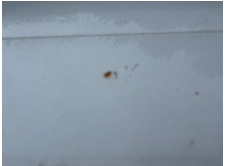
Dach (Delle, Rost, Kratzer)
