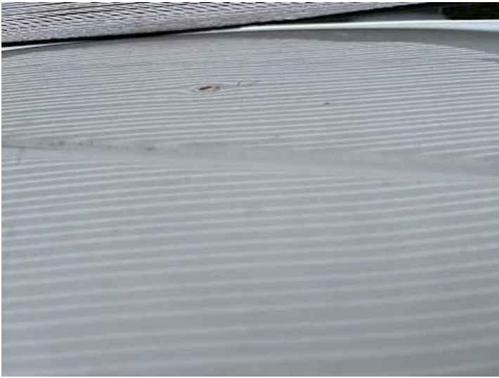
Dach (Delle, Rost, Kratzer)
