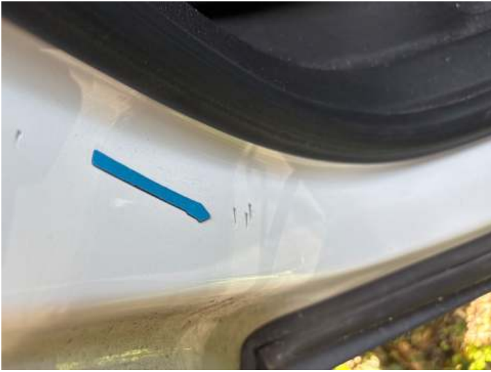
Schweller rechts (Kratzer)
