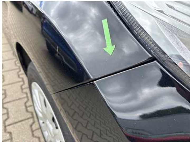
Kotflügel vorne rechts (Spaltmaße ungenau)
