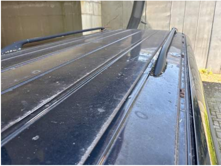
Dach (Delle, Verformung)
