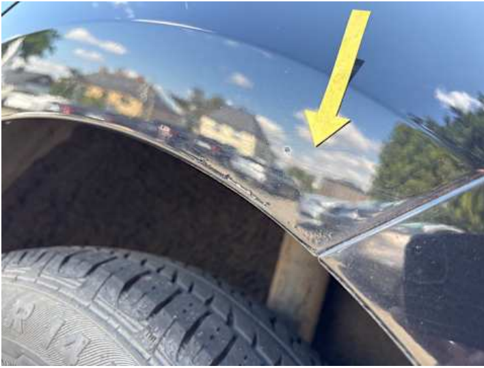
Seitenteil hinten links (Rost)
