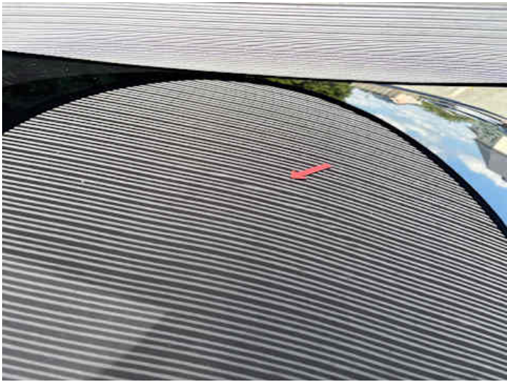
Dach (Verformung)
