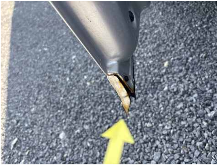
Fahrtür (Rost, Kratzer)
