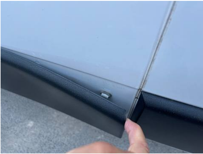
Seitenteil hinten links (Riss/Bruch)
