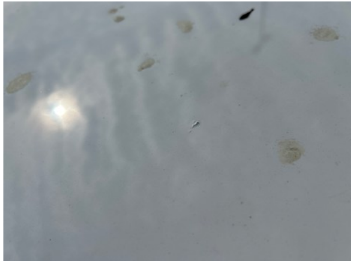
Dach (Lackschaden)
