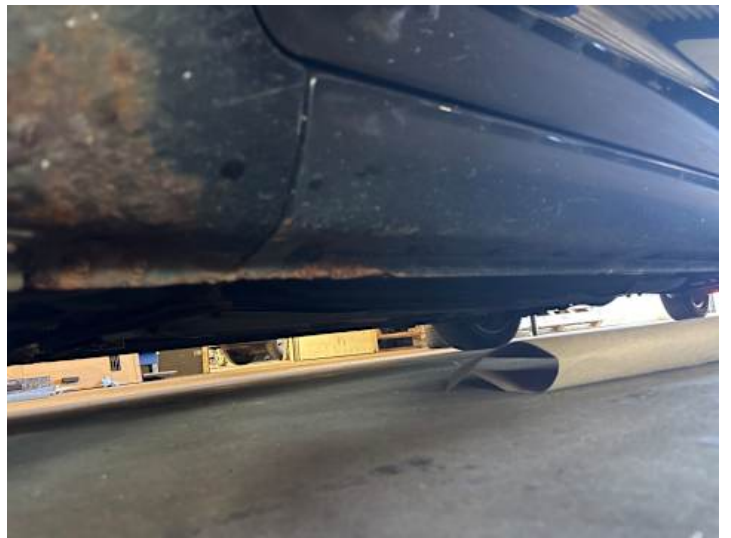
Schweller links (Kratzer, Delle, Rost)
