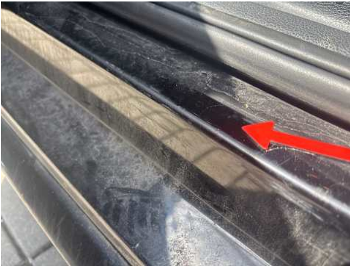
Schweller links (Rost)
