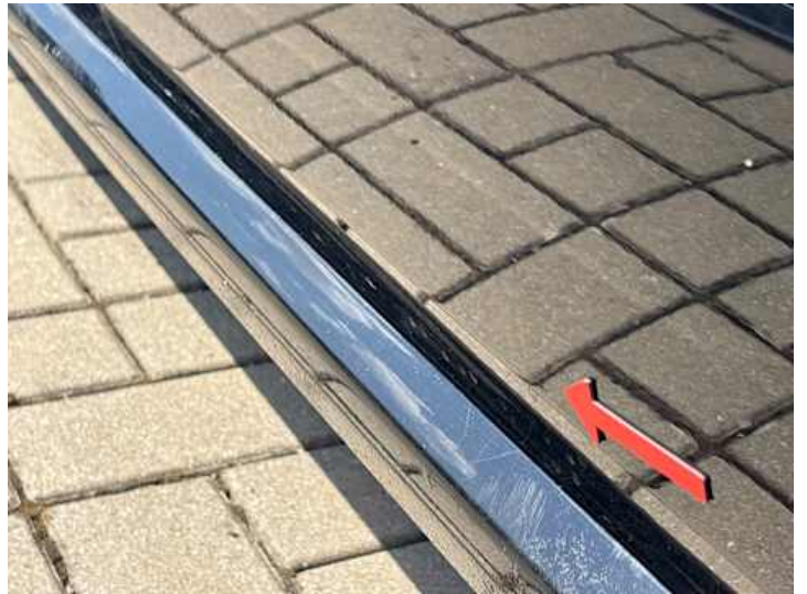
Türe hinten links (Rost)
