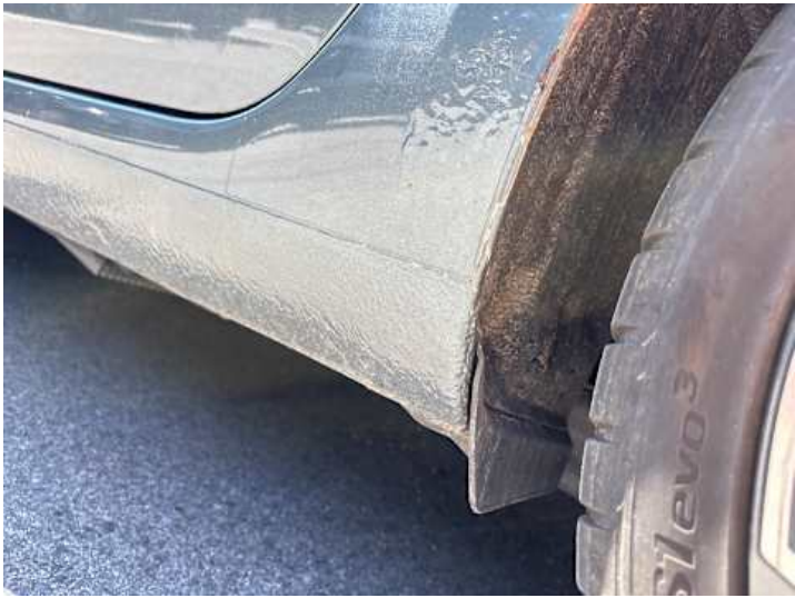
Schweller links (Rost)
