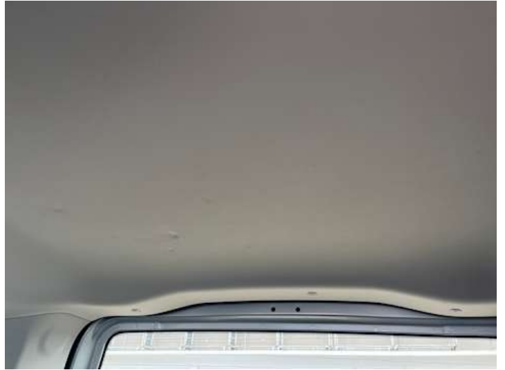
Innenraum (Diverse Schäden)
