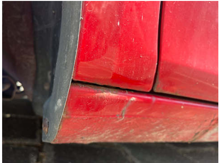
Kotflügel vorne links (Rost)
