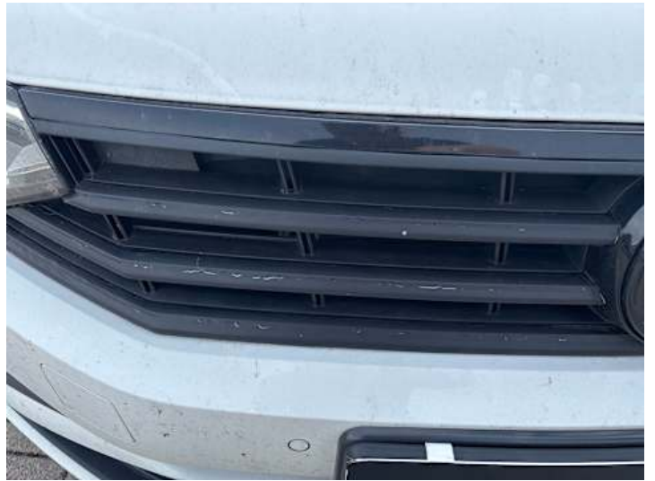
Stoßstange vorne (Anderer Schaden): Folie rissig
