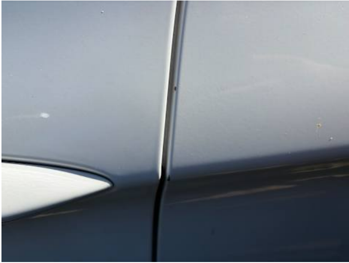
Türe hinten rechts (Steinschlag, Rost)
