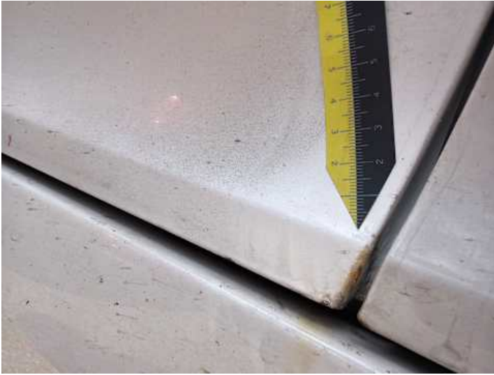
Türe hinten rechts (Rost, Unsachgemäß instand gesetzt)
