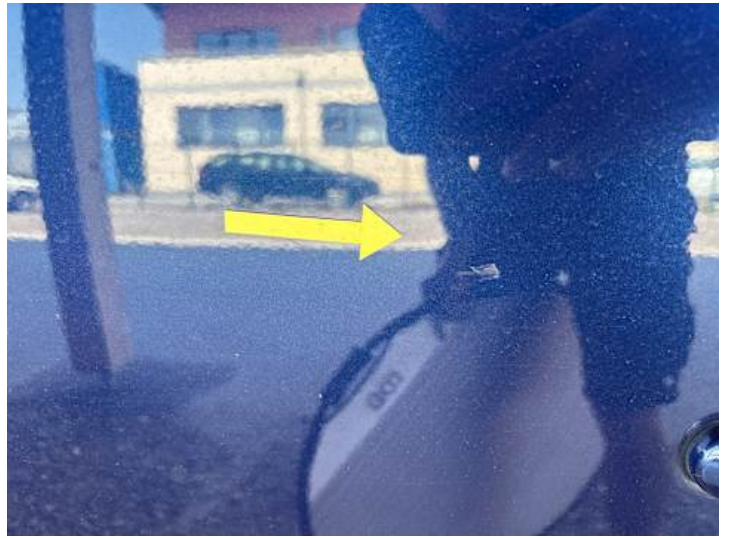
Türe hinten rechts (Delle)
