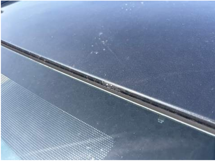
Dach (Lackschaden, Rost, Steinschlag, Unsachgemäß instand gesetzt)
