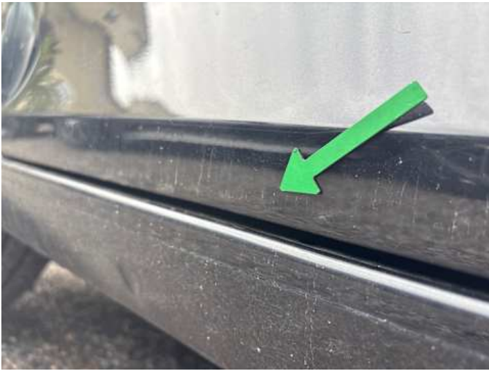
Türe hinten rechts (Rost)
