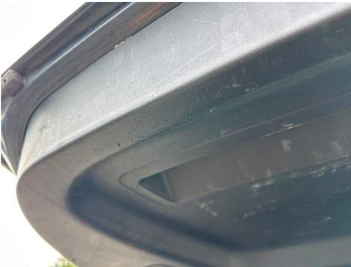
Innenraum (Diverse Schäden)
