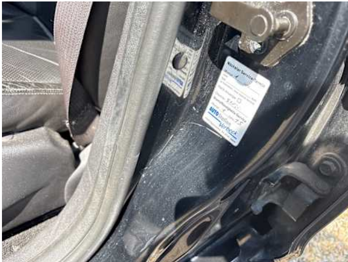
Schweller links (Lackschaden, Rost, Kratzer)
