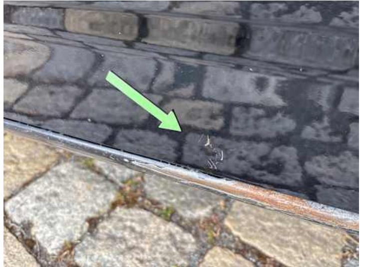
Fahrtür (Lackschaden, Rost)
