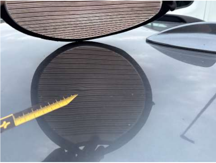
Dach (Delle, Verformung)
