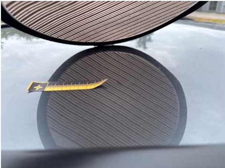
Dach (Delle, Verformung)
