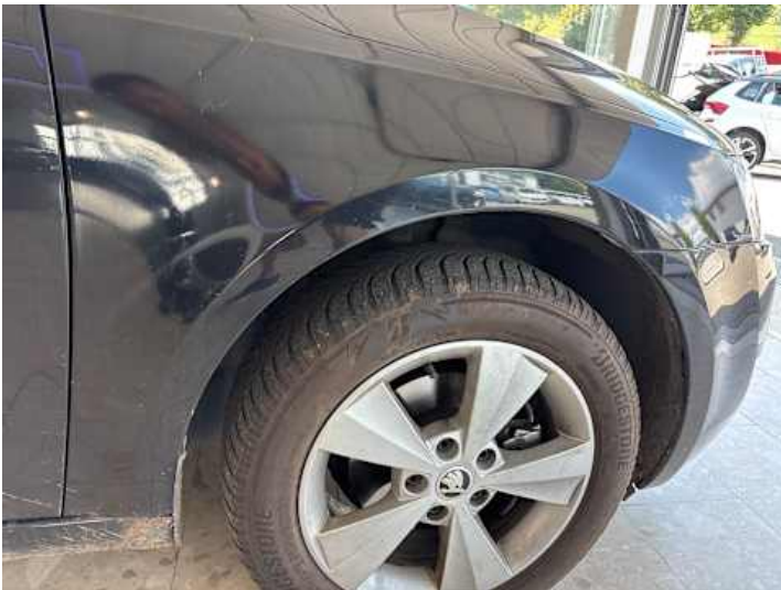
Kotflügel vorne rechts (Unsachgemäß instand gesetzt, Rost)
