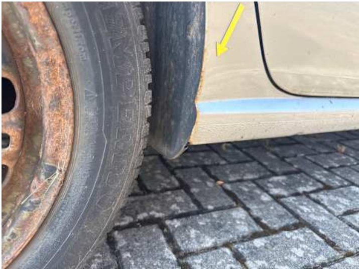
Seitenteil hinten rechts (Rost)
