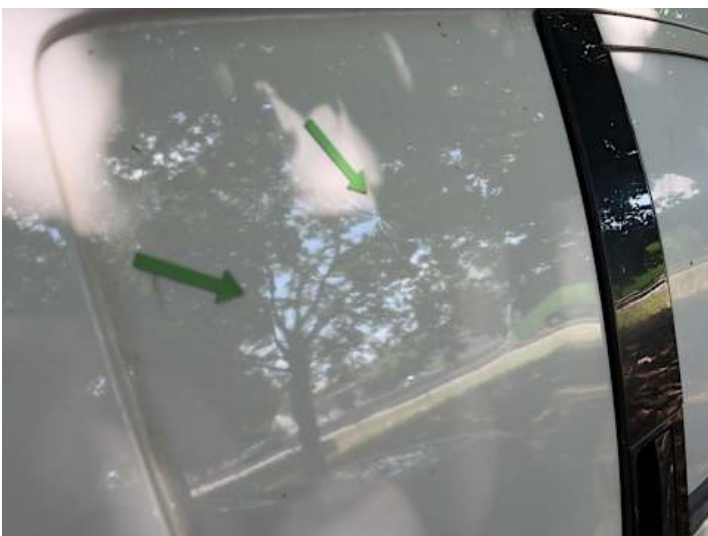
Seitenteil hinten rechts (Verformung)
