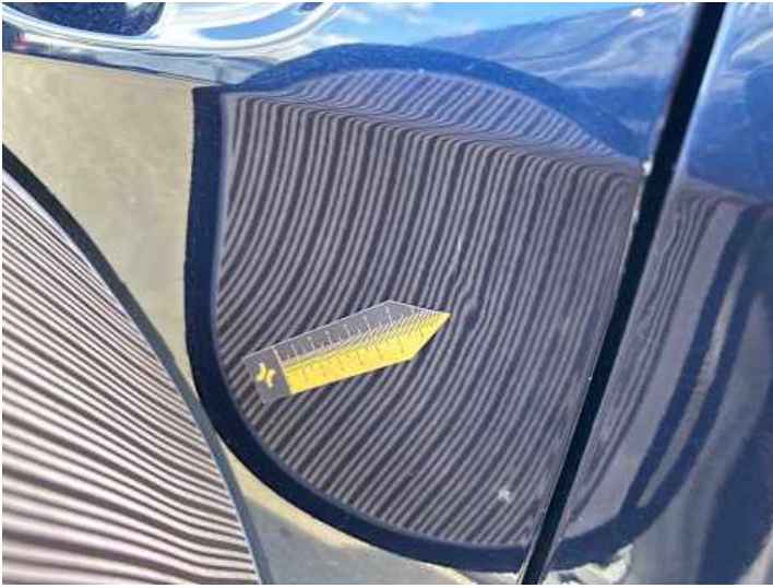
Fahrtür (Verformung, Delle)
