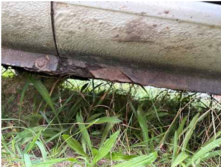
Schweller links (Rost)
