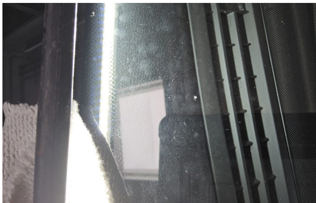
Steinschlag mit Rissbildung (DEKRA)
