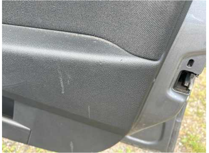
Innenraum (Diverse Schäden, Brandloch)
