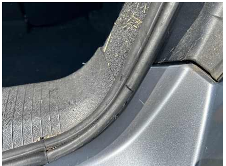
Innenraum (Diverse Schäden, Brandloch)
