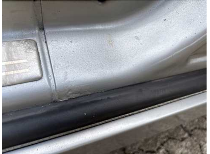
Schweller links (Rost)
