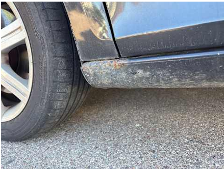
Schweller links (Rost)
