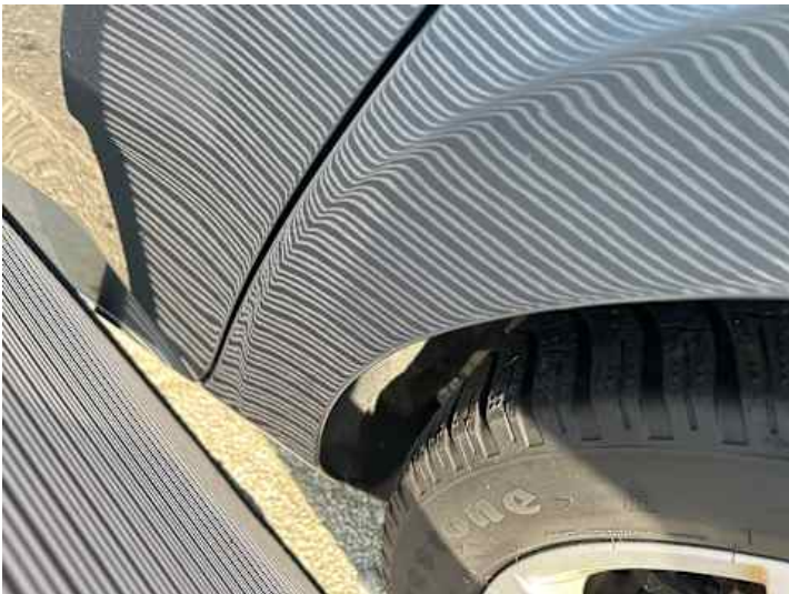
Seitenteil hinten links (Unsachgemäß instand gesetzt)
