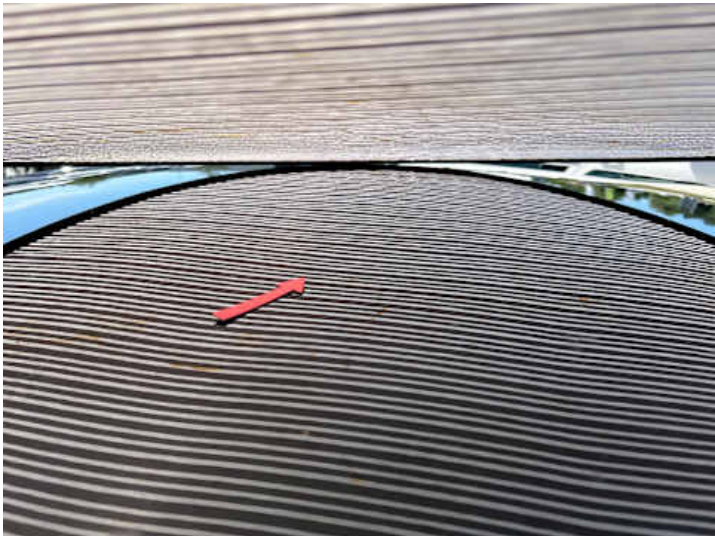
Dach (Verformung)
