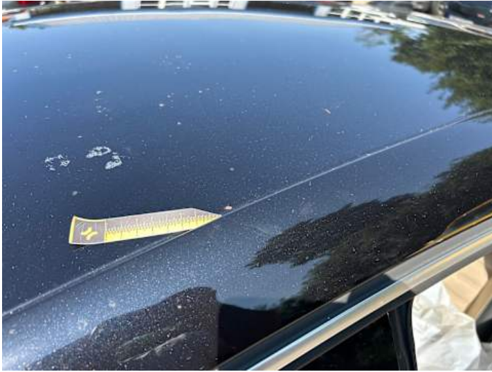
Dach (Steinschlag, Rost)
