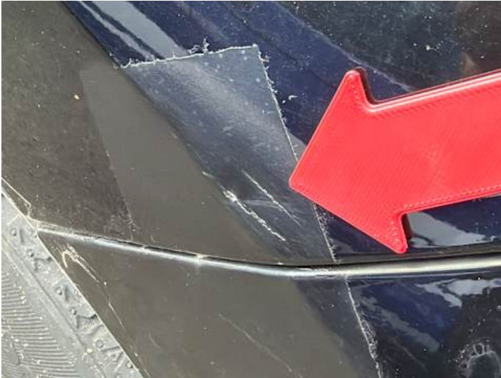
Seitenteil hinten links (Unsachgemäß instand gesetzt, Delle)
