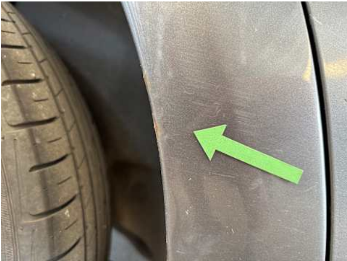
Seitenteil hinten rechts (Delle, Rost)
